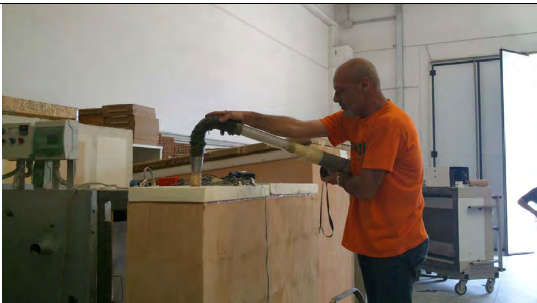
Particolari delle fasi di insufflaggio
